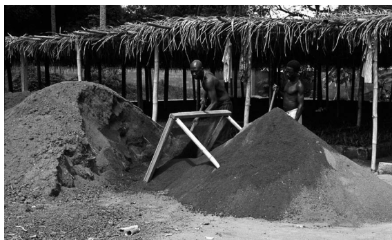
Figure 2.1. Chantier de tamisage.
